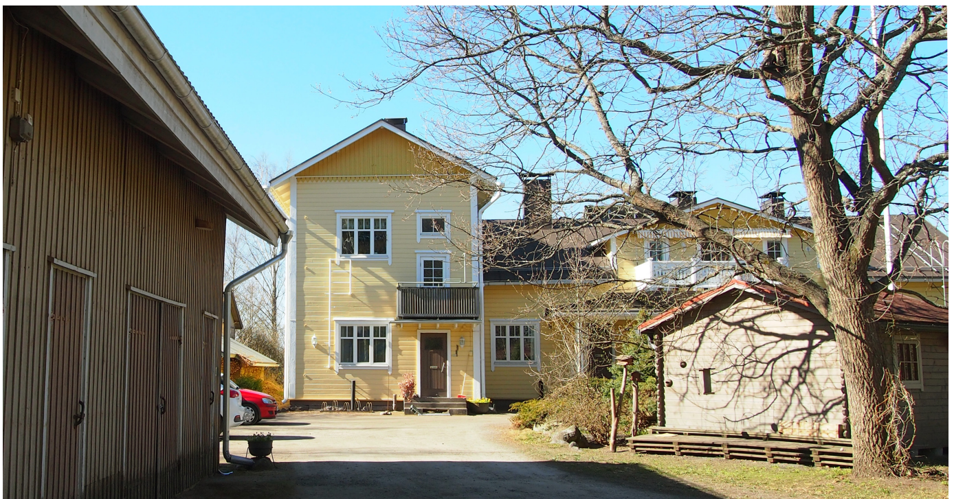
Skyttälän sotilasvirkatalon paikalle 1869–99 rakennettu hirsitalo. Vasemmalle jää piharakennus vuodelta 1882.
