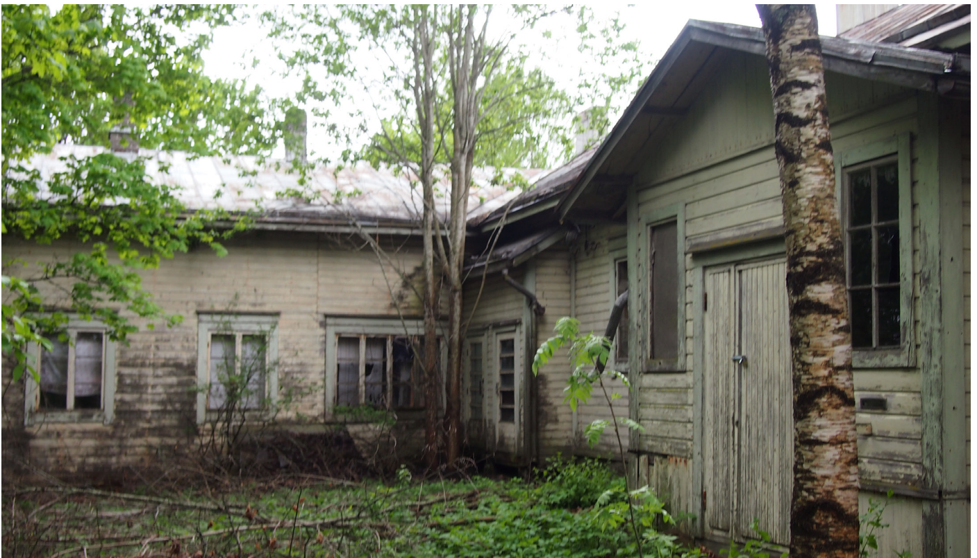
Sama rakennus tyhjillään keväällä 2017.
