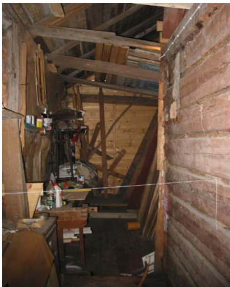
Rakennuksen sisällä näkyy lämpimän osan hirsiseinä oikealla ja kylmän osan rankorakenteinen lautaseinä vasemmalla. Kuva Jiri Hietanen.
