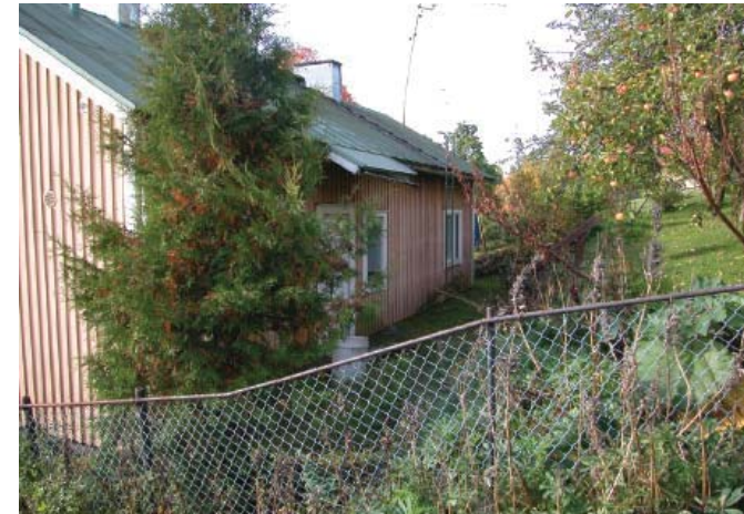
Linjalta avautuu näkymä jyrkälle rinnetontille.
