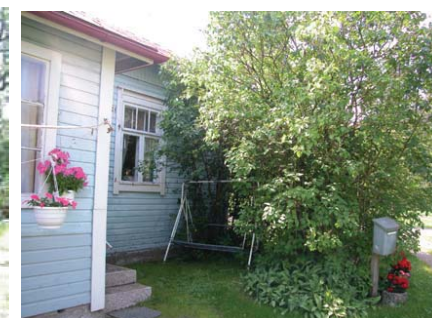
Päärakennus ja sisäänkäynnin yhteydessä oleva syreenimaja.
